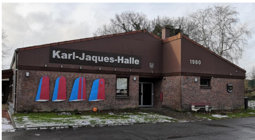
Abbildung 18: Karl-Jaques-Halle im Ortsteil Tökendorf (CIMA 2024)
