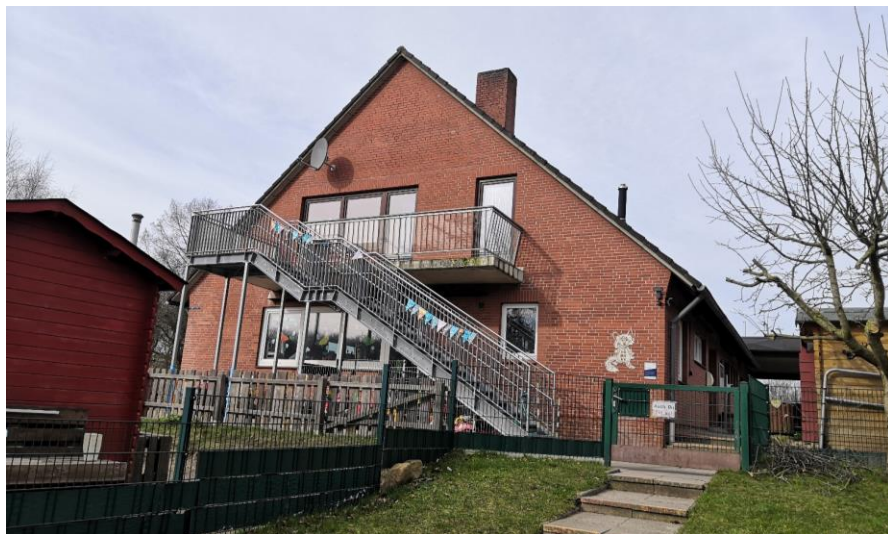
Abbildung 23: KiTa TöDoLi im Ortsteil Tökendorf (CIMA 2024)
